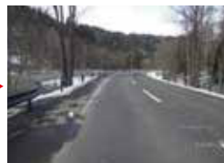
国道38号(南富良野)
