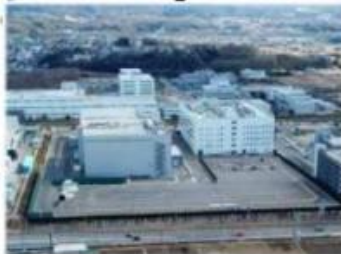
花本テクニカルセンター 愛知県 豊田市
