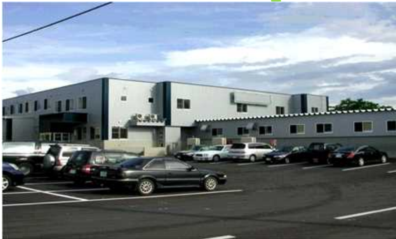
施設近景（かみふらの工房食肉センター）
