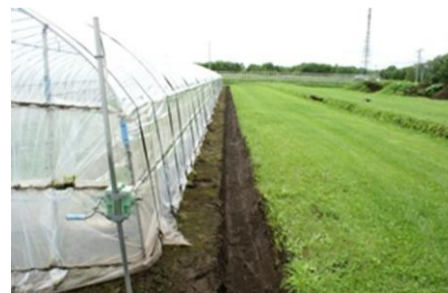
ほ場周りの明きょ設置で安定生産を！
