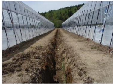
ハウス周辺明きょの事例
