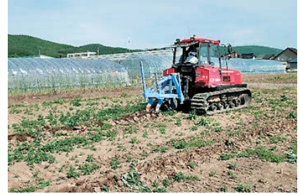
施工中の走行
