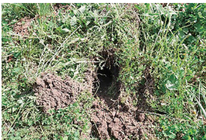
施工後の通水空洞
