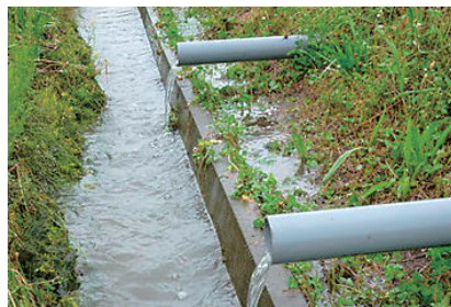
塩ビ管からの排水状況(No.4・5)
