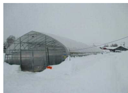
写真 降雪期間のハウス外観
