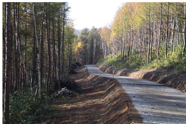
林業専用道西和東線（和寒町） 林道を補完し、集材や木材の搬出を効率的に行えるよう配置 （10t 積トラック等の通行を想定）
