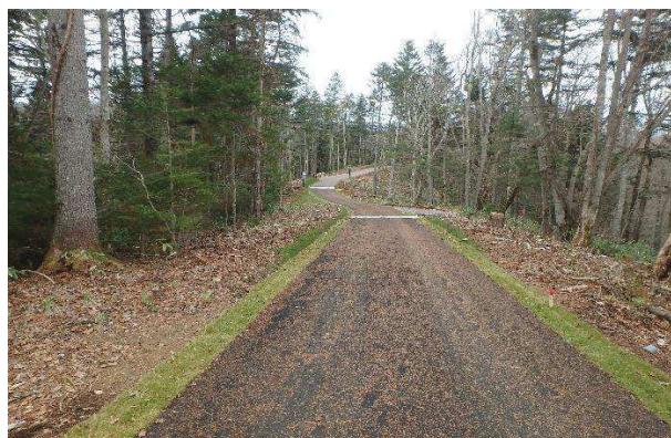
林業生産基盤整備道 アリサラップ支線（占冠村） 森林整備への利用はもとより、山村の生活環境の改善や地域振興などの役割も担う路網 （20t 積トラック等の通行を想定）
