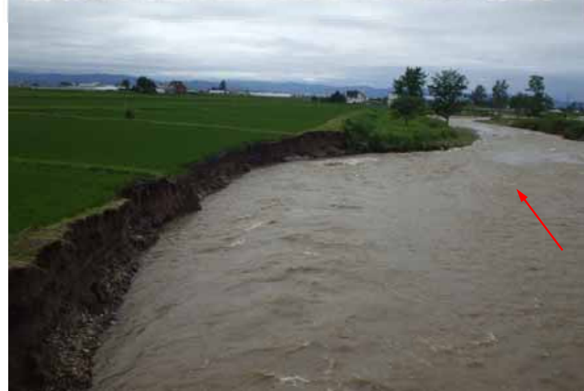
倉沼川万年橋下流決壊状況 (H30. 7. 4撮影)
