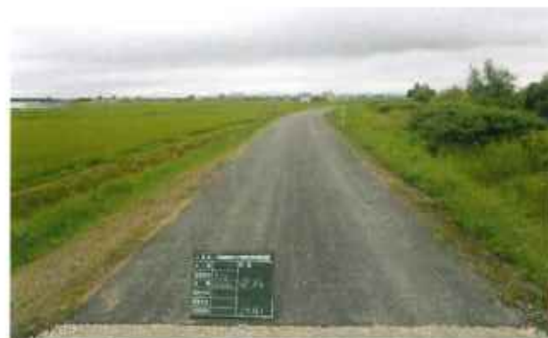
堤防天端保護の実施状況
