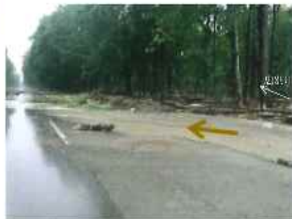
写真-2 道路への越水、河畔林内への流下
