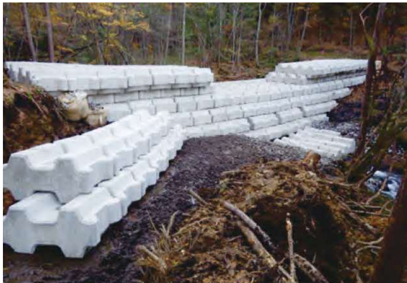
図 5.4 鹿ノ瀬川に設置したブロック堰堤
