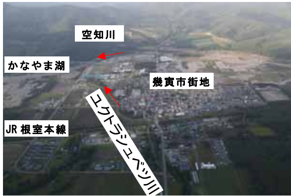
平成 28 年 8 月の浸水被害 (南富良野町幾寅市街地)
