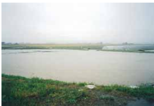
平成13年9月の浸水被害(ヌッカシ富良野川)
