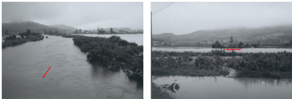
比布川 昭和56年8月の被害状況
