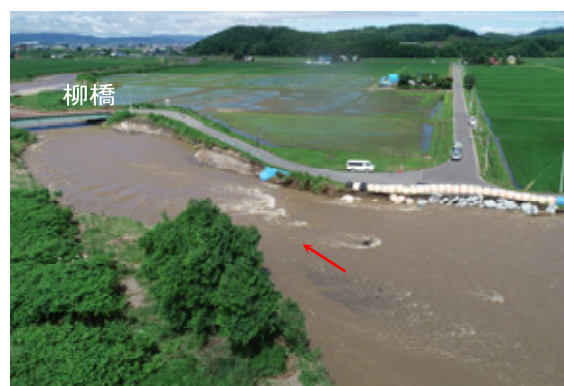
倉沼川 平成30年7月の被害状況
