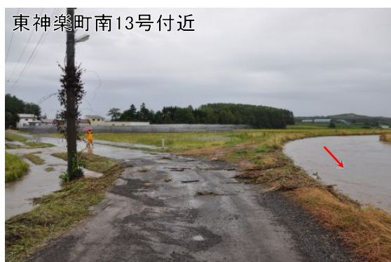
八千代川 平成23年9月の被害状況
