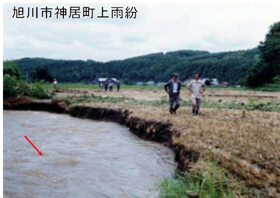
雨紛川 昭和56年8月の被害状況
