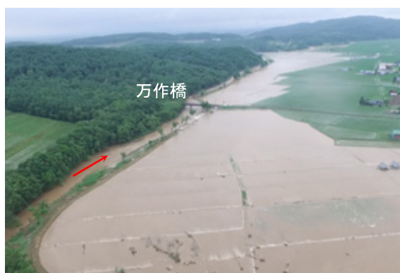
ペーパン川 平成30年7月の被害状況
