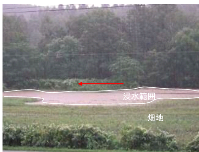
平成28年8月豪雨による農地の浸水被害 智恵文川（大沢橋より約1.5km下流）
