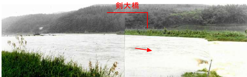
昭和56年8月豪雨による農地の浸水被害（剣大橋下流右岸側より撮影）
