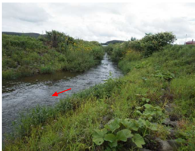
ちれつぷ 智烈布橋（風連別川合流点から0.3km）より上流
