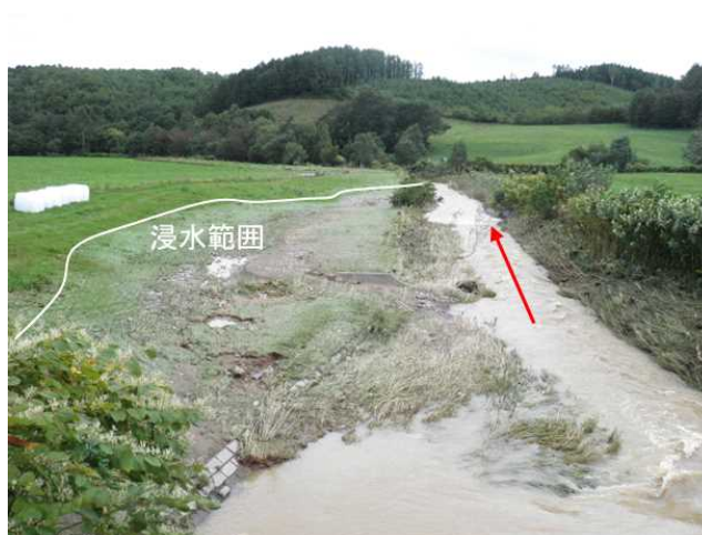
平成28年8月豪雨による農地の浸水被害 智南川（大智橋より約100m下流）
