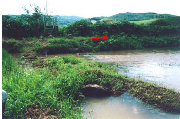
平成12年7月豪雨による農地の浸水被害（大成川合流点より約200m上流右岸側より撮影）
