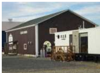
農珈屋(奥)と米麦屋(手前)
