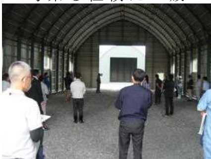
建設中の倉庫
